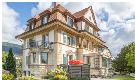
Lengnau Ehemalige Fabrikantenvilla
